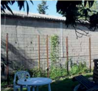
In den Bühler Werkstätten konnte die schon lange gewünschte Mauerbegrünung umgesetzt werden.
