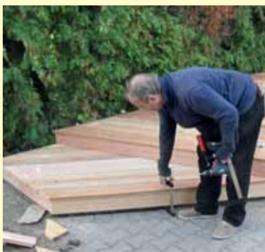
Ein Holzpodest konnte im Außenbereich der Bühler Werkstätten installiert werden.
